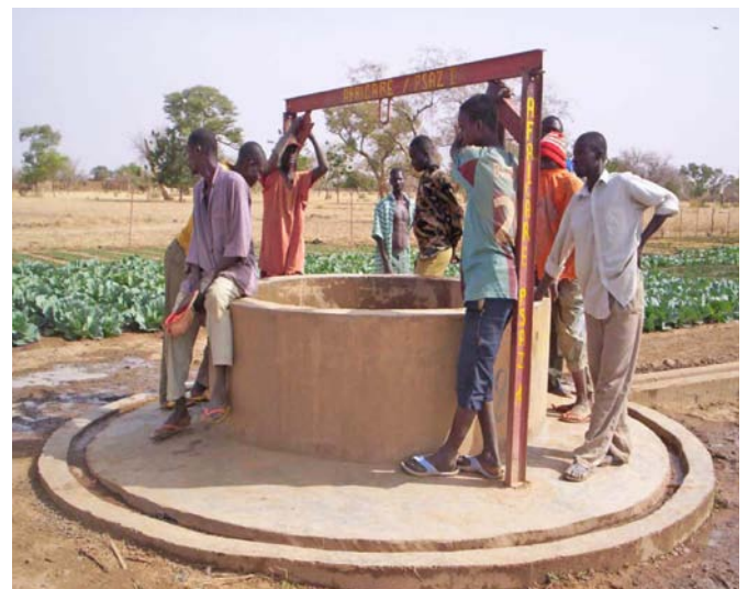
Puits à parois revêtu (moellons ou buses)
